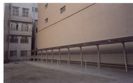
新設・自転車駐輪場
